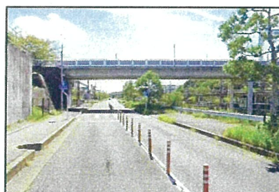
橋梁全景 (中部1182号線側)
